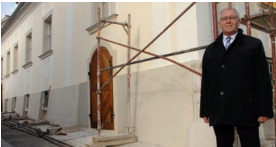
Das Haus Herrengasse 7 kurz vor der Fertigstellung
