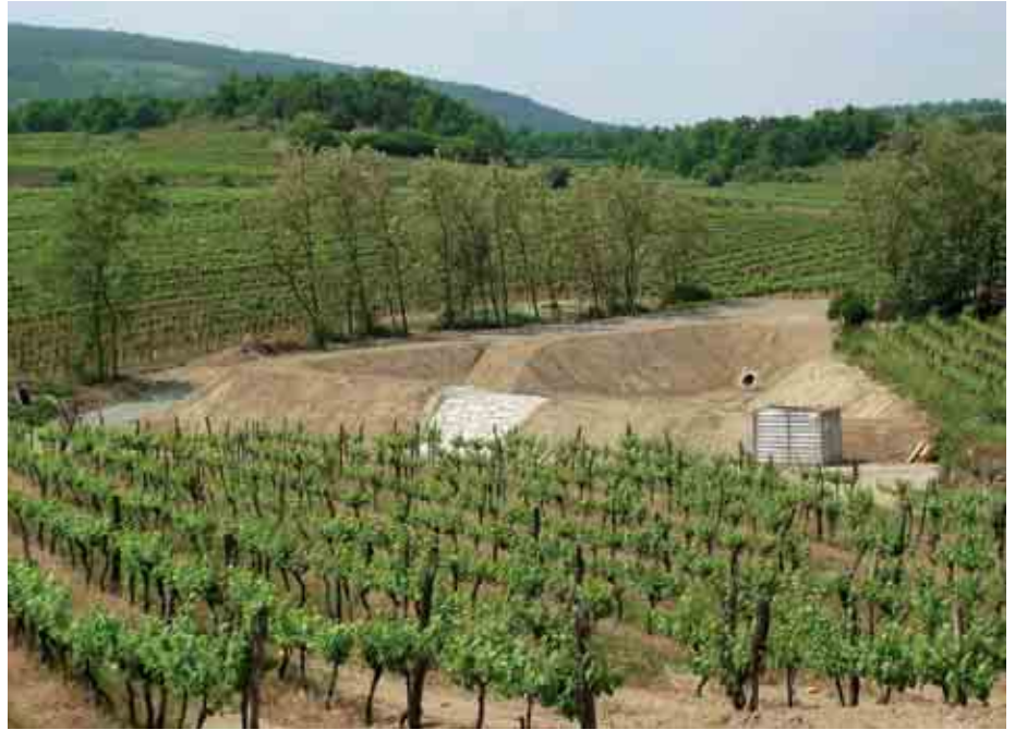
Das untere Becken konnte bereits fertiggestellt werden.
